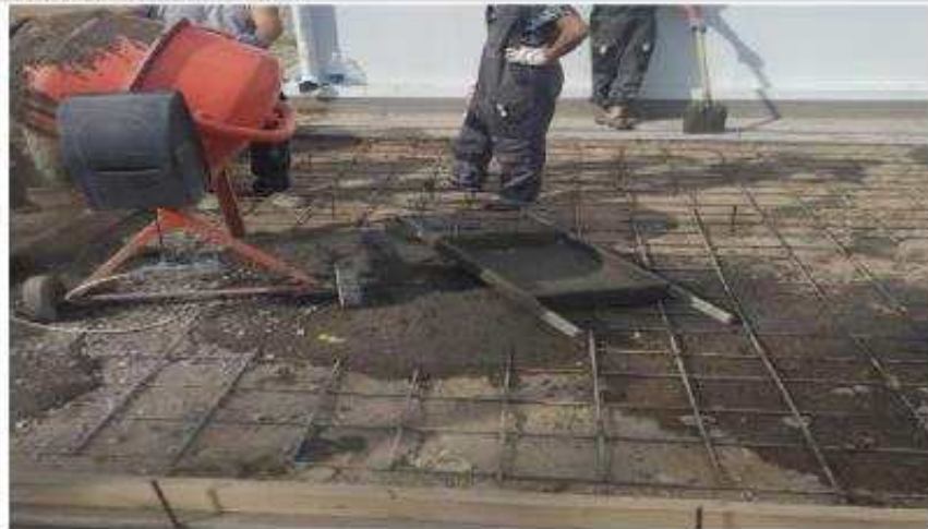
외부 문댕크 설치 받침대 설치
