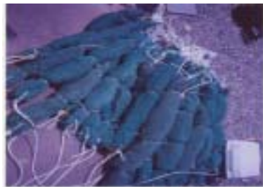
폐어망을 시공하기 위해 제작한 상태 오수처리시설 폭기조내 폐어망을 시공한 모습
