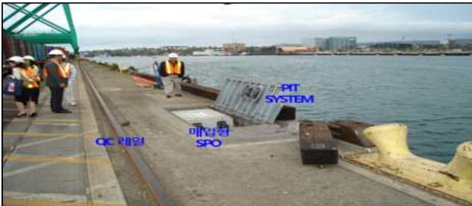
〈그림 4-6〉 LA항 매입형 SPO 설치 예
