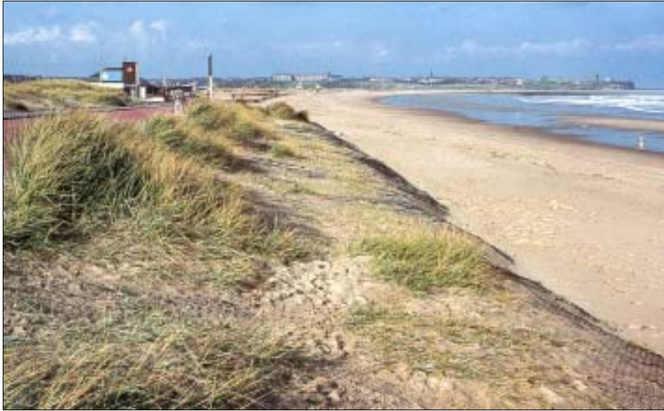
〈그림 5-19〉 르노 매트리스(Reno Mattress) 공법에 의한 시공지
